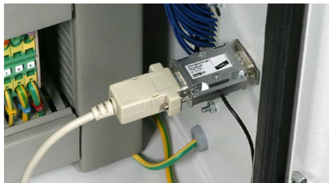
Adaptateur de protection antisurtension, raccordement Sub-D en version prise mâle – prise femelle.
