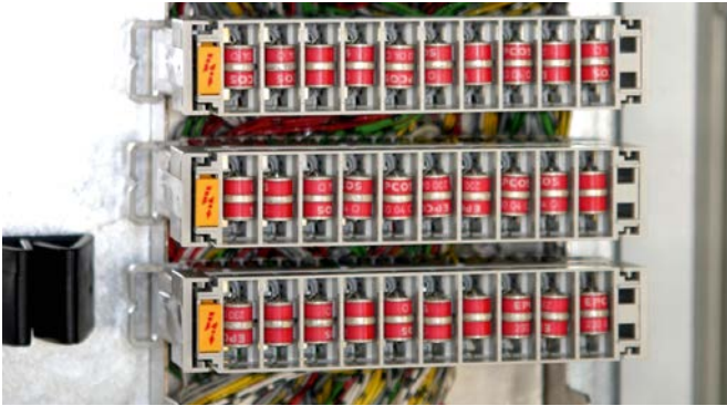
Parafoudres enfichables pour systèmes LSA de type 2/10. Variante bloc de protection pour 10 paires de conducteurs avec éléments de protection individuellement remplaçables.
