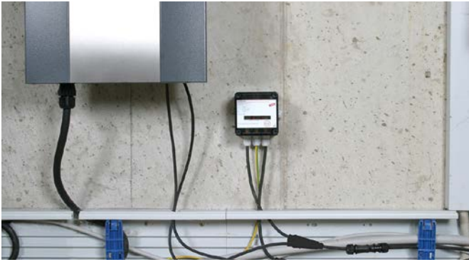
Câbles de raccordement préfabriqués pour un raccordement simple des strings au parafoudre DEHNcube et à l'onduleur.
