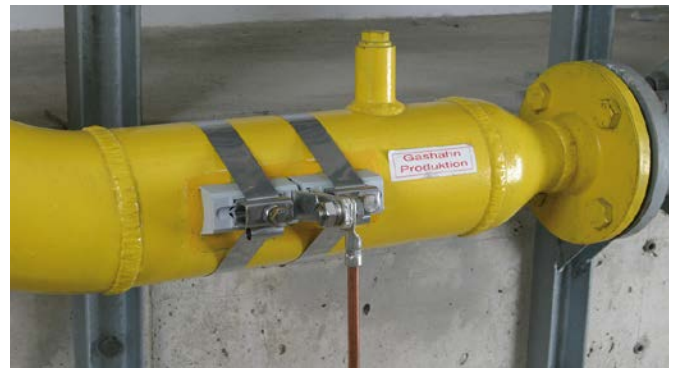
Collier de serrage pour assurer le contact électrique de tubes dans des zones à risque d'explosion, en application de l'équilibrage de potentiel pour la protection contre la foudre selon NF EN 62305-3.
