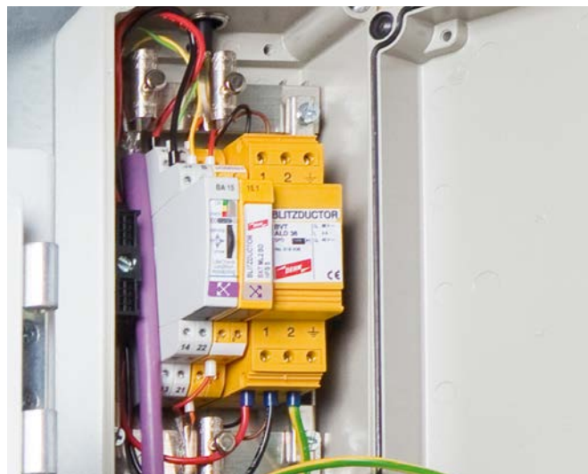
Parafoudre compact avec connexion par bornes à visser pour lignes multifilaires et ainsi pour montage sur rail DIN.
